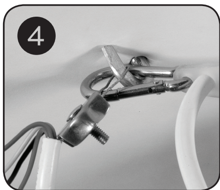
Fig. 4 • Raccomandiamo l'utilizzo del filo di sicurezza in acciaio (presente all'interno del cavo di linea del diffusore) da fissare al gancio a soffitto per rendere l'installazione ancora più sicura.
